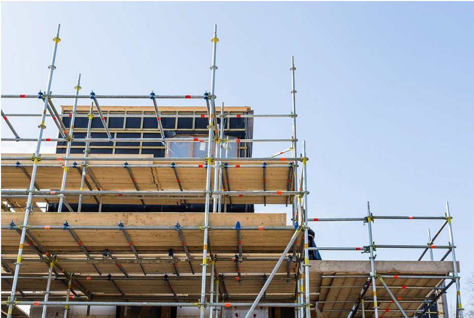
Woningen in aanbouw
